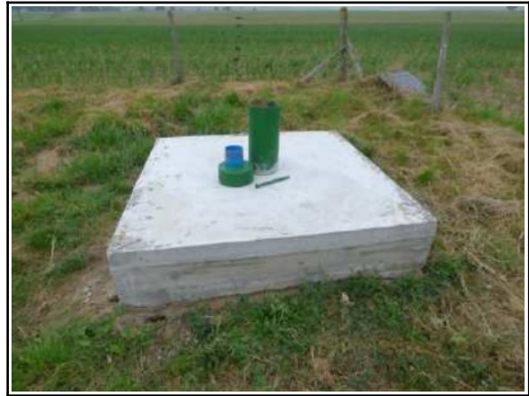
Le piézomètre situé à proximité de la station de pompage
