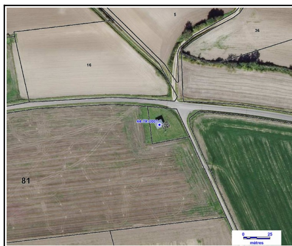
La station de pompage située en bordure de la RD 316
