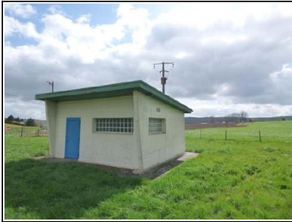
La station de pompage abritant le forage
